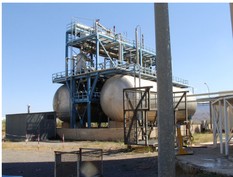
Figuur 2-6 Voorbeelden van thermische opslag in gesmolten zouten, a) bij de SolarOne 10 MW toren demonstratiecentrale in de VS (12 uur opslag), b) bij het Plataforma Solar.
